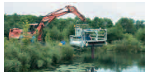
Le racleur de boues de fond KLAWA juste avant son intervention.
